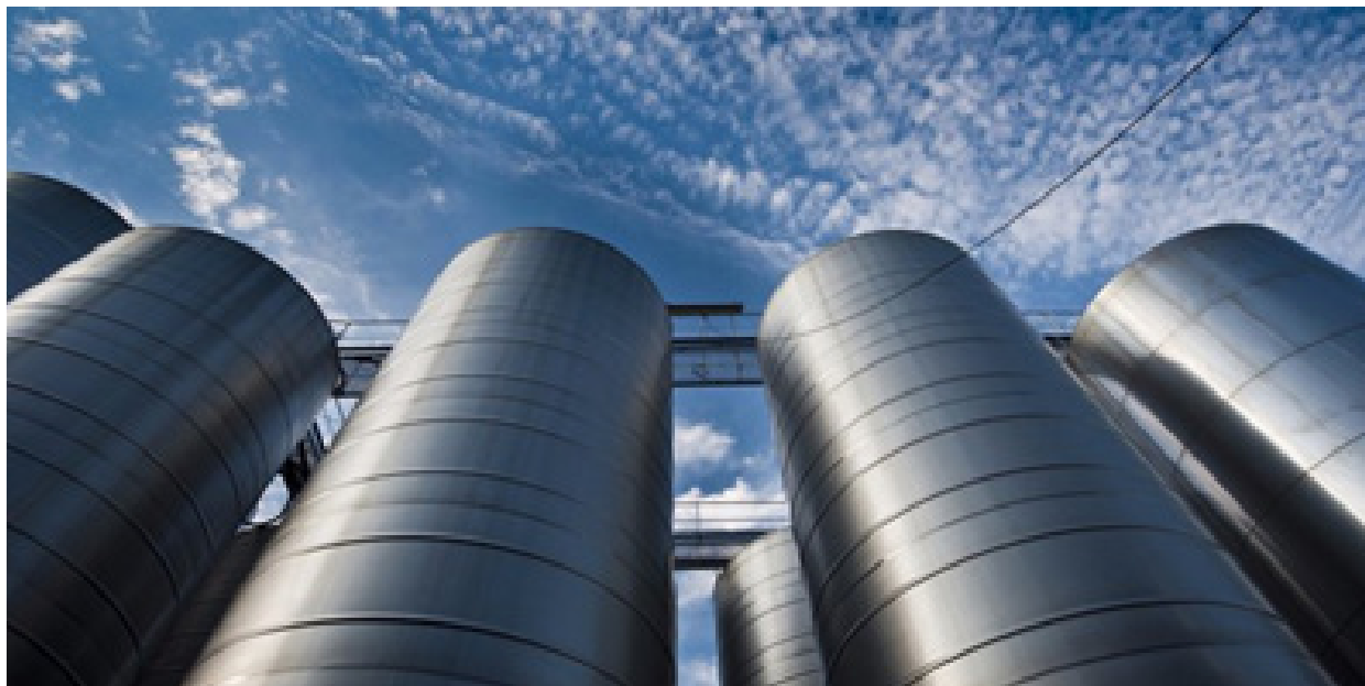
Fig. 12 Elena, I. (n.d.). Silos [photograph]. [RG3]
